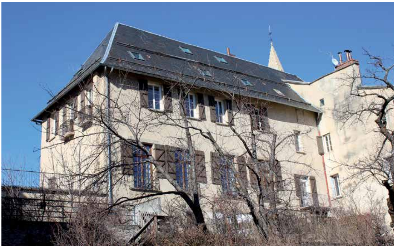
L'ancienne sous-préfecture abrite de nos jours des logements (Photo M.F.)
