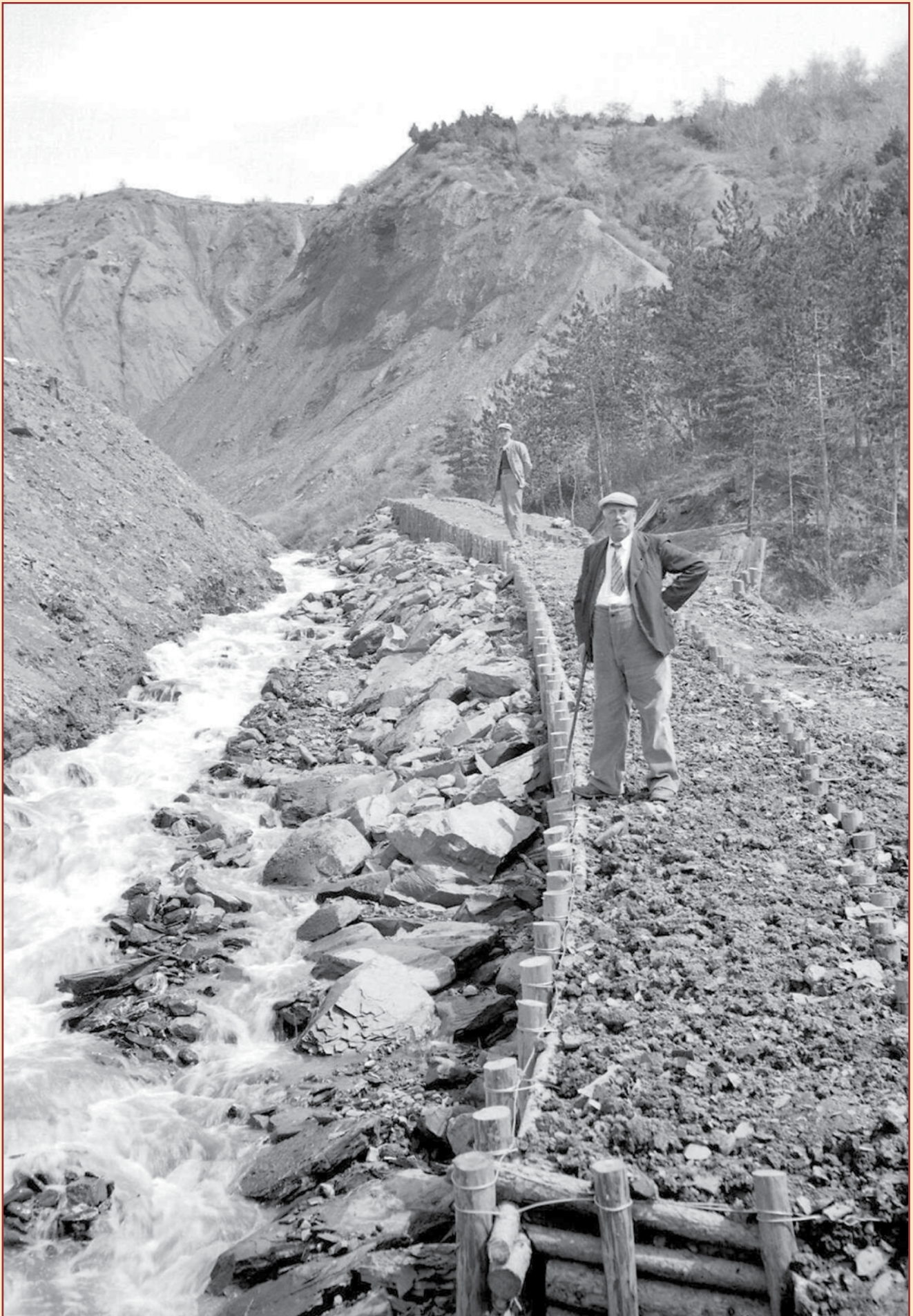
Torrent de Sainte-Marthe : chenal aménagé dans le glissement de terrain qui s'est produit en 1932, et digue en bois. (Photo RTM 05).
