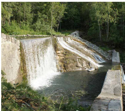
Seuil aménagé à Baratier © Camille Bertuletti
